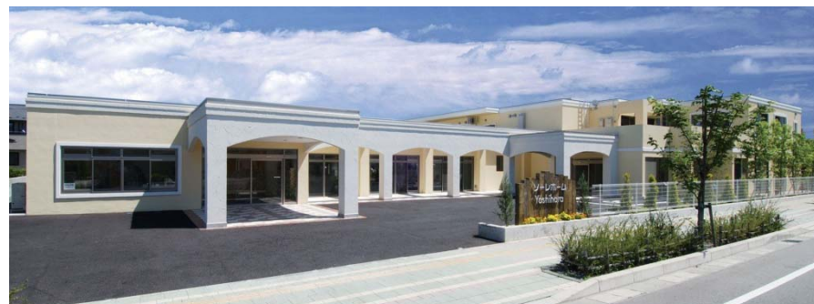
高専賃 建物外観
