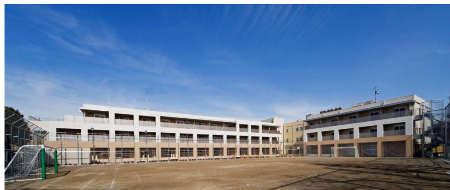
建物外観(改修後)
