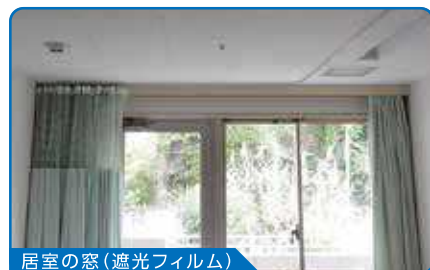
居室の窓(遮光フィルム)
