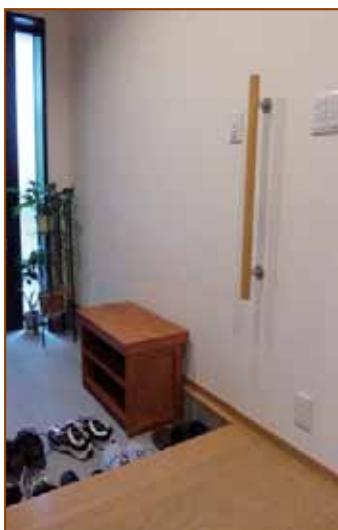
運動機能の低下に対応して、縦手すりやベンチを設置。
